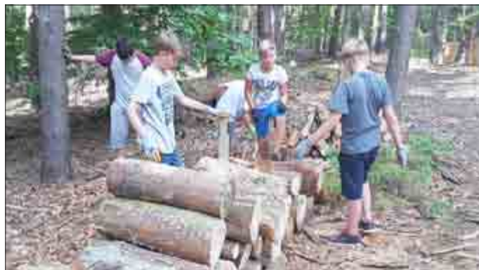
Ferieneinsatz an der Mitmachbaustelle „Spechtschmiede“ in den Saalleiten
