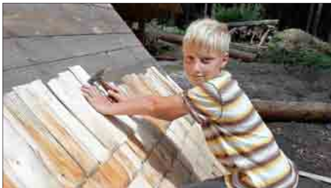
Eric nagelt in einem Ferieneinsatz Holzschindeln an die Spechtschmiede an.
