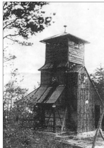
Die Konzeption sieht den Wiederaufbau des Turmes als massiven Holzturm mit einer Gesamthöhe von ca. 20 m und einer Grundfläche von ca. 5 x 5 m vor. Dieser soll unter Verwendung von einheimischen Hölzern (als nachwachsender Rohstoff) mit einem Treppenaufgang und einer überdachten Aussichtsplattform versehen werden. Der Turm soll als zentraler Aussichtspunkt (nicht nur für das unmittelbare Gemeindegebiet) fungieren.
