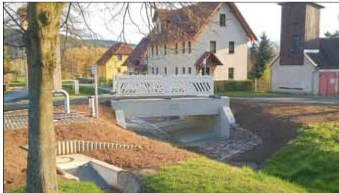
Mit der Vergrößerung des Durchflussprofils des Bauwerkes sollte, die Brücke für zukünftige Hochwassereignisse kein Problem mehr darstellen.
